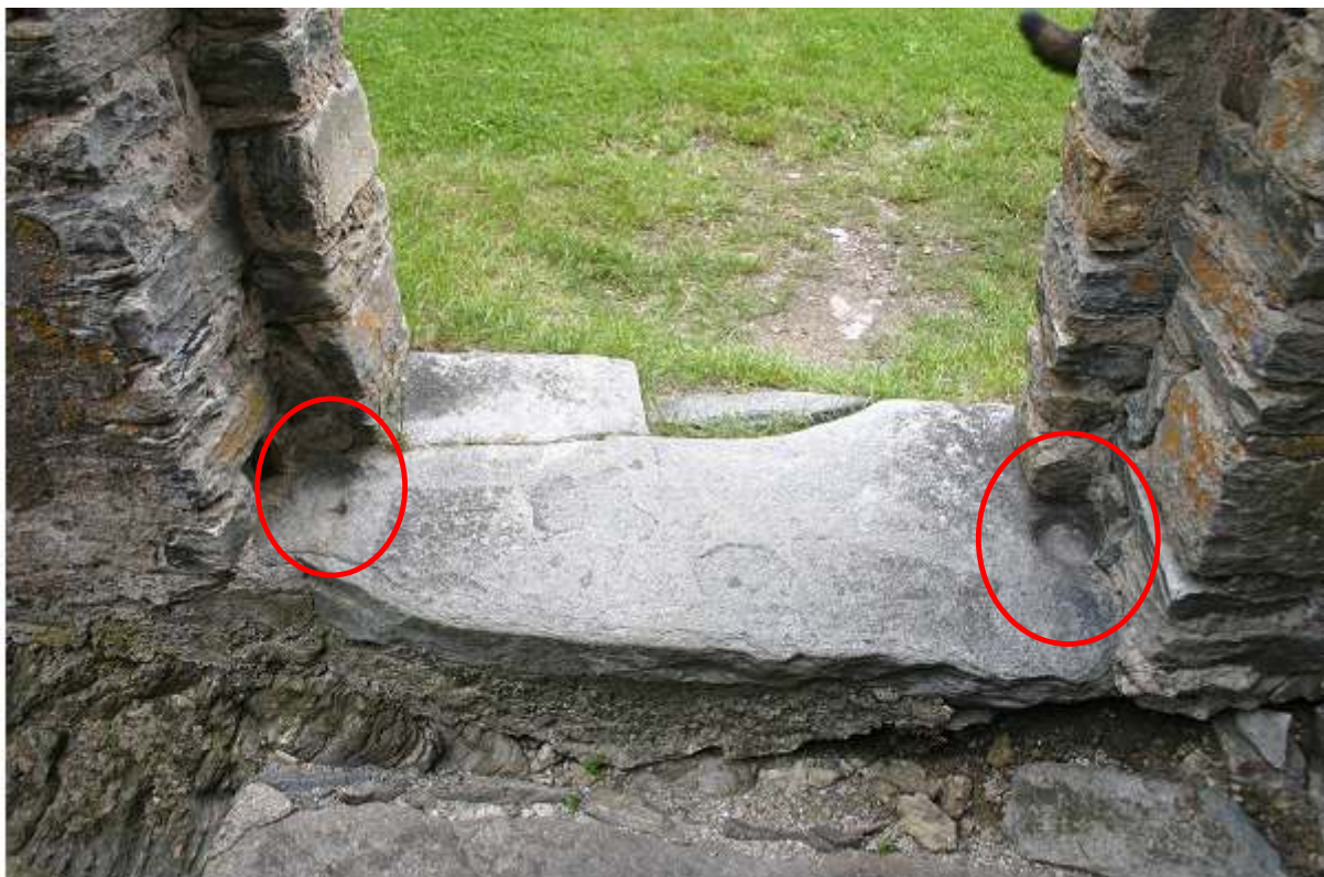
Lagerpfannen (Läuferschalen) für Türpfosten
