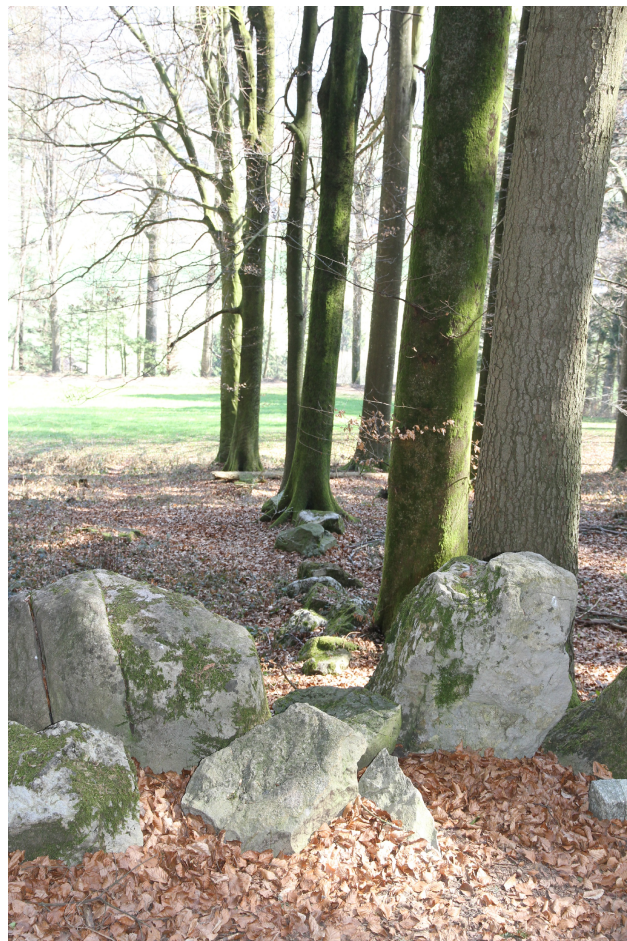
Blick von der Mitte der Mauer auf den senkrecht dazu östlich verlaufenden Mauerrest.
